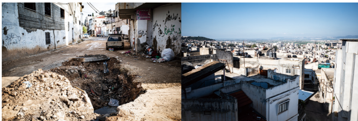
[左] キャンプ内の道路はイスラエル軍によりあちこち掘り返されており、下水の溢れているところも。[右] コンクリートの建物がひしめき合うジェニン難民キャンプ。
